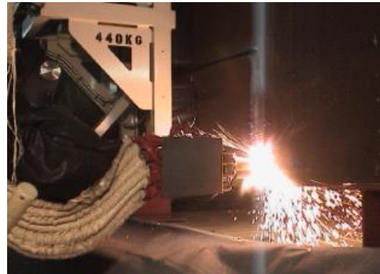
切断アームまたは内臓構造物の切断風景
