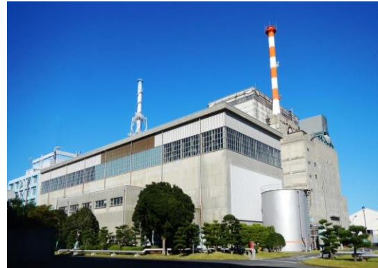
廃炉が進む東海発電所（外観）
