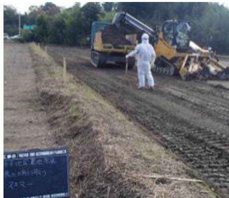
写真 3 農地の除染状況(表土の剥取り)
