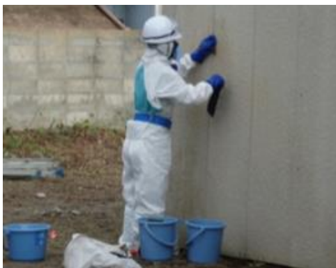
写真 2 外壁の除染状況(拭取り[濡拭き])
