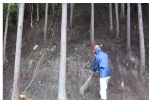
写真 5 森林の除染状況(堆積物残渣の除去)
