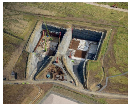
図 2 掘削後の床面、壁面建設中のボールド
