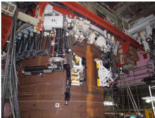
遠隔解体風景または解体装置
