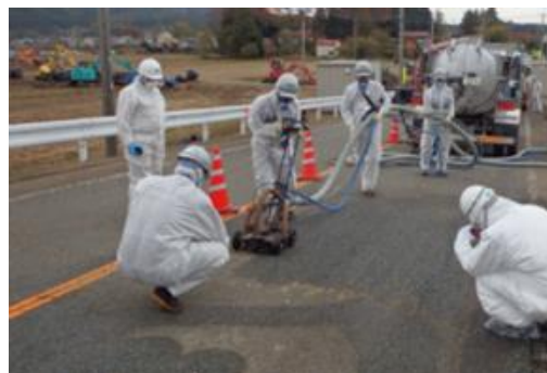
写真 4 道路(舗装面)の除染状況
