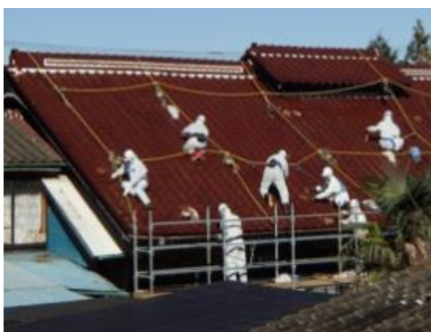
写真 1 屋根の除染状況(拭取り[乾拭き])
