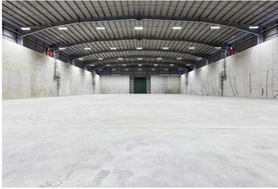
図3 完成したボールド内部
