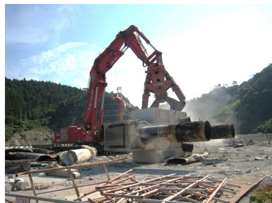
ワイヤーソー切断後大型機で圧砕
