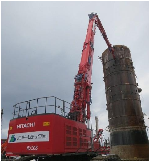
ウォータージェット切断後の 鉄骨カッターで解体
