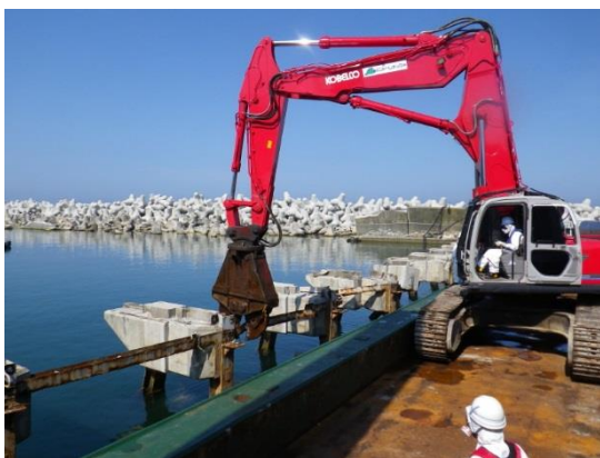
台船上より50t機鉄骨カッターでの作業
