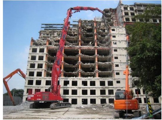
15 階建て社宅解体
