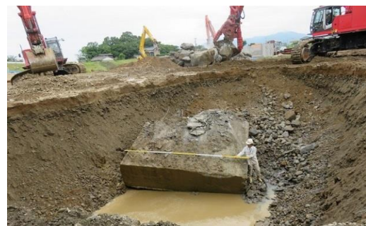
基礎（80 t 超）の撤去作業
