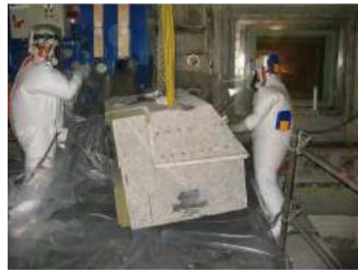
図 3 配管付の解体コンクリートブロック
