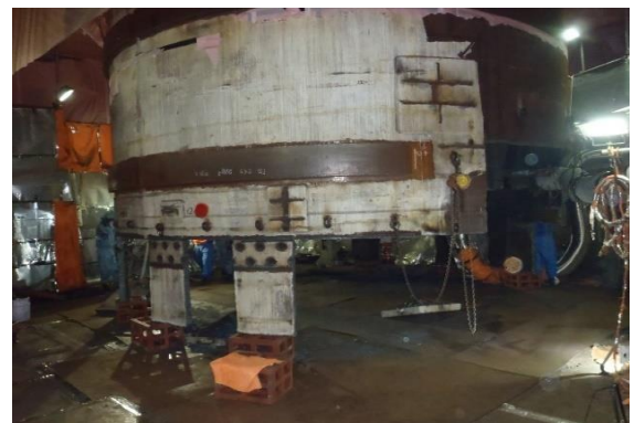
写真7 熱交換器本体 ジャッキダウン（東海発電所）
