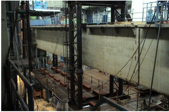
写真3 燃料取替機トランスポーター ジャッキダウン前（東海発電所）
