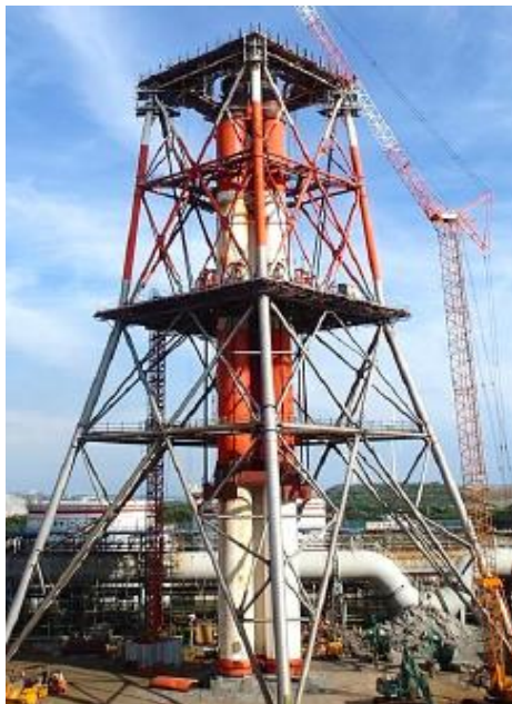
写真 2 煙突ジャッキダウン工法 (某火力発電所)
