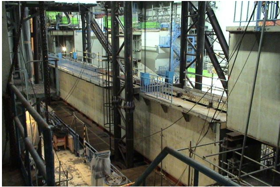
写真4 燃料取替機トランスポーター ジャッキダウン後（東海発電所）
