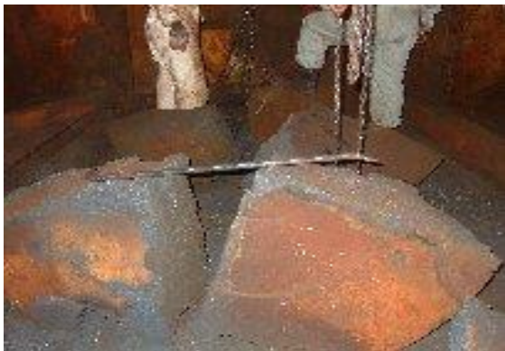
写真2 サイクロトロンの解体
