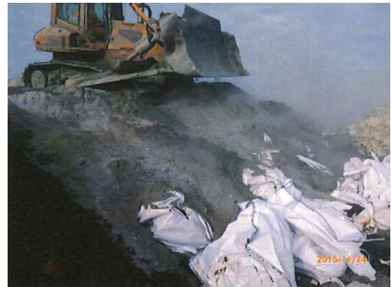
図 4 鑄造物の埋立て
