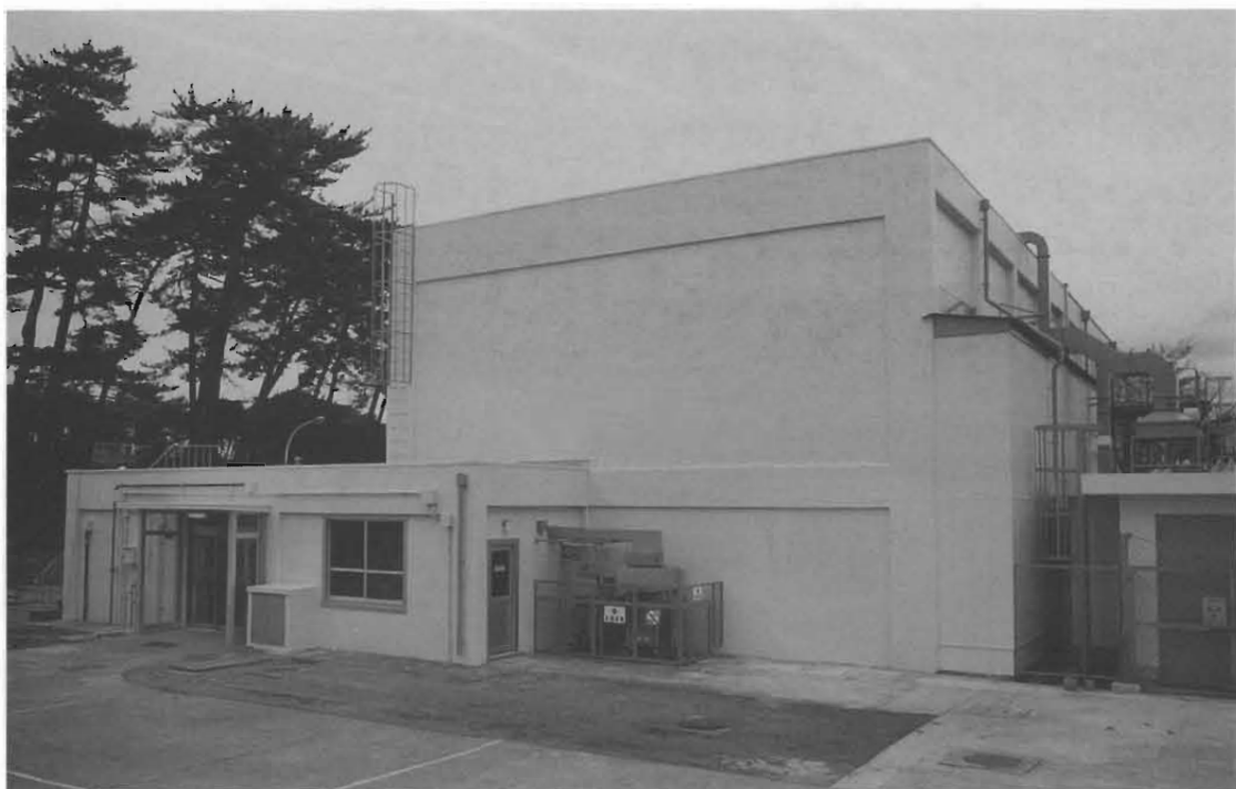
図2 VHTRCの置かれている開発試験室建屋
