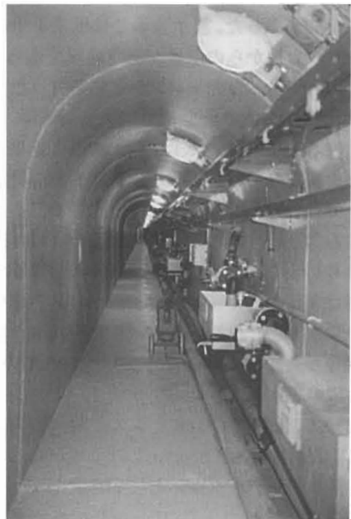
排水、雨水、地下水等のモニタリング地下道
