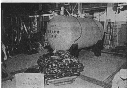
写真4 凝縮液貯槽解体片
