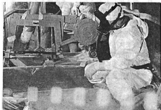
携帯鋸盤による解体室内での細断作業
