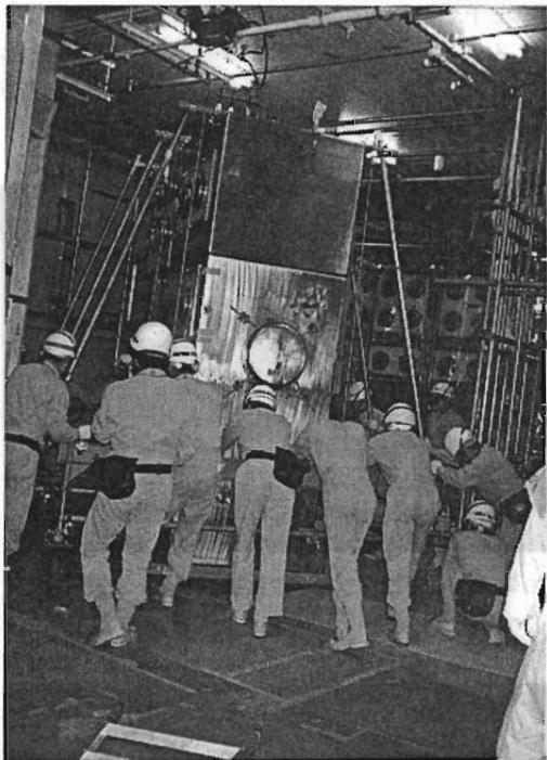
写真3 グローブボックス移動状況
