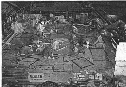
炉頂部シール溶接作業
