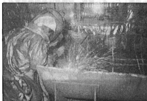
写真5 酸素アーク切断作業
