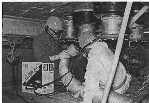
炉体下部昇降水管撤去後、樹脂注入作業
