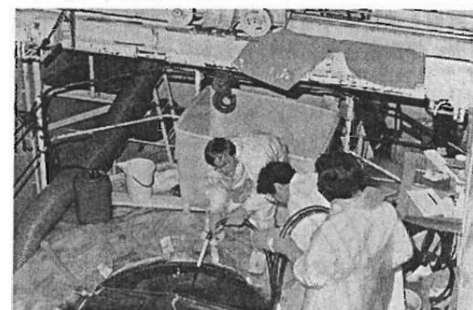
図5 サービスプールの化学除染(ノエル社より提供)
